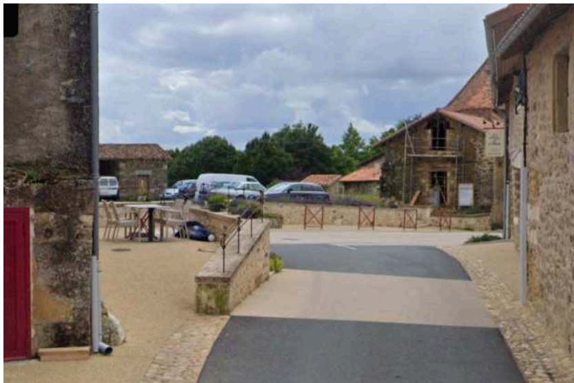
Terrasse commerçante et marquage résine Saint-Martin de Fressengeas (24)
