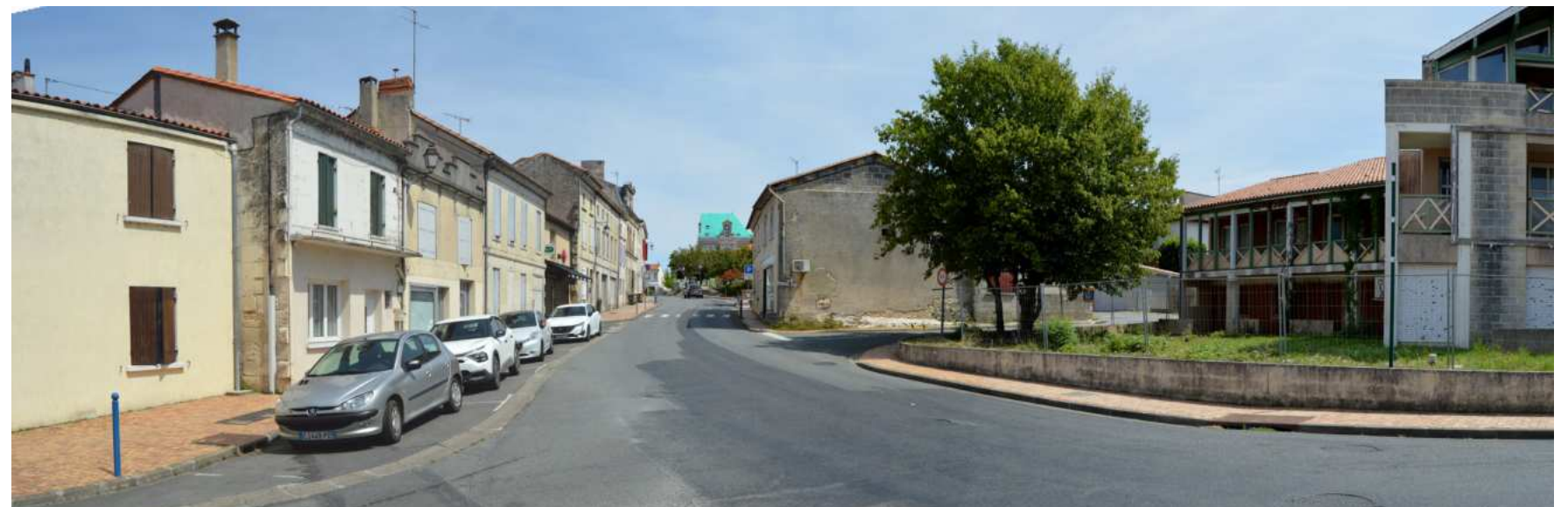
L'entrée sud de la place du puits qui chante est aussi marquée par un étranglement bâti qui réduit la visibilité des automobilistes sortants des rues des Buis et des Cordiers
